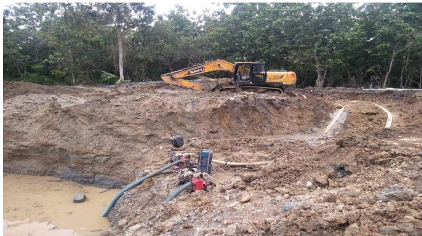
Gambar 2. Penggalian tanah menggunakan ekskavator di Desa Wumbubangka (Sumber : Dokumentasi pribadi, 2022)
